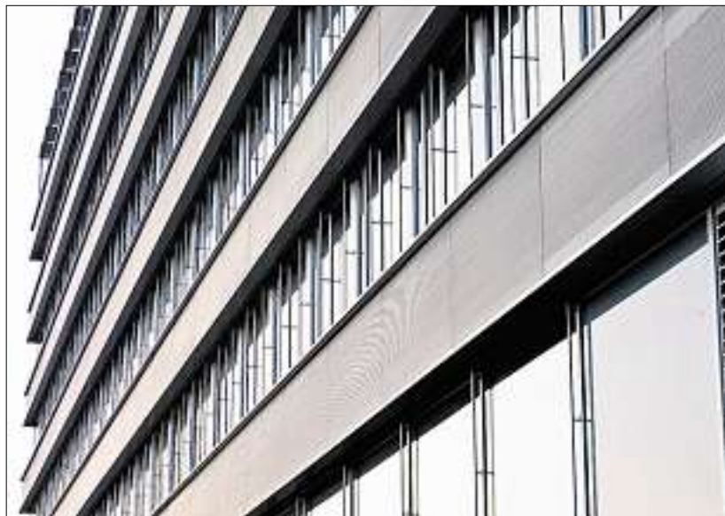
Die moderne Hausfassade aus Holz am Portikon-Bau im Glattpark. (zvg)
