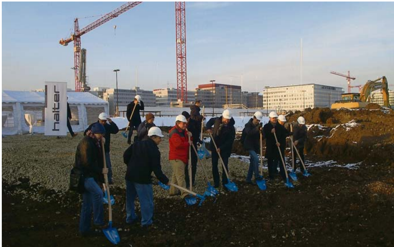
Die künftigen Eigentümer der Wohnungen im «Uptown» setzten selbst die Schaufel an.
