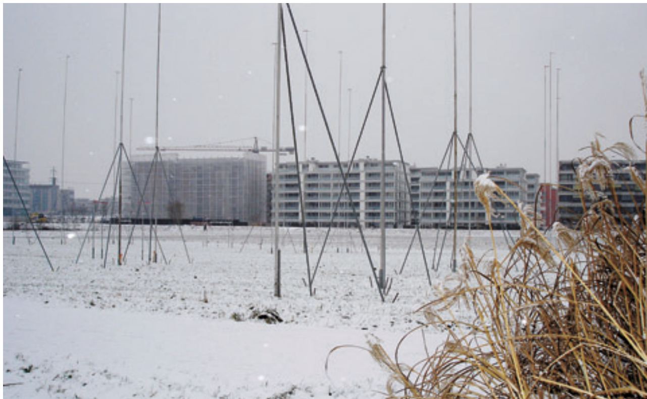
Auf dem vormaligen Oberhauserriet, dem heutigen Glattpark Opfikon, steht in Bälde ein neuer Bauschub bevor.
