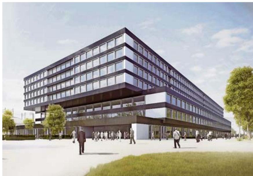
... erhält aber einen anderen, markanten Vorsprung. Die Geschossflächen entsprechen beinahe einem Fussballfeld.
