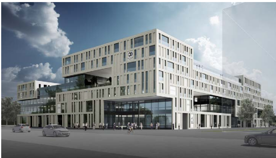
Am Tor zum Glattpark: Wright Place, vorne Thurgauerstrasse, rechts Wright-Strasse
