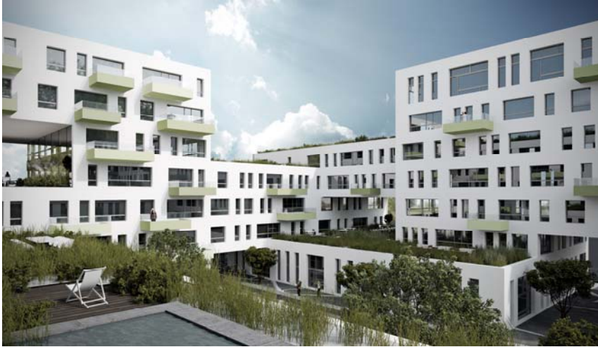
Wright Place mit begrünten Dächern, Terrassen und Innenhöfen
