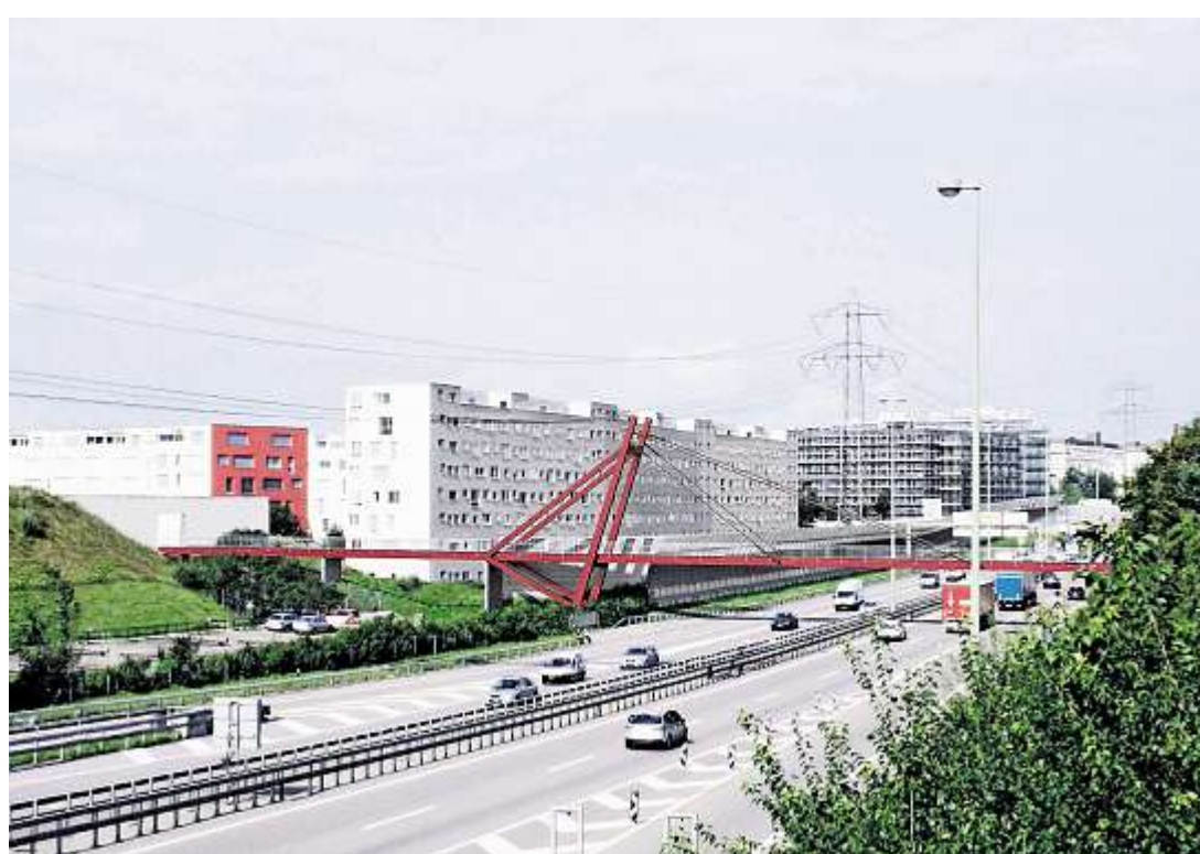
Rund 2,7 Millionen Franken gibt die Stadt Opfikon für die neue Fuss- und Radwegbrücke über die Autobahn A1 aus. Der Übergang verbindet den Stadtteil Glattpark (links) mit dem Quartier Fall-/Böschewiesen. Max Bosshard
