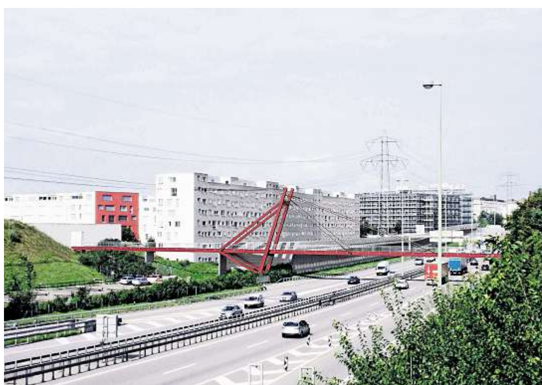
Rund 2,7 Millionen Franken gibt die Stadt Opfikon für die neue Fuss- und Radwegbrücke über die Autobahn A1 aus. Der Übergang verbindet den Stadtteil Glattpark (links) mit dem Quartier Fall-/Böschewiesen. Max Bosshard
