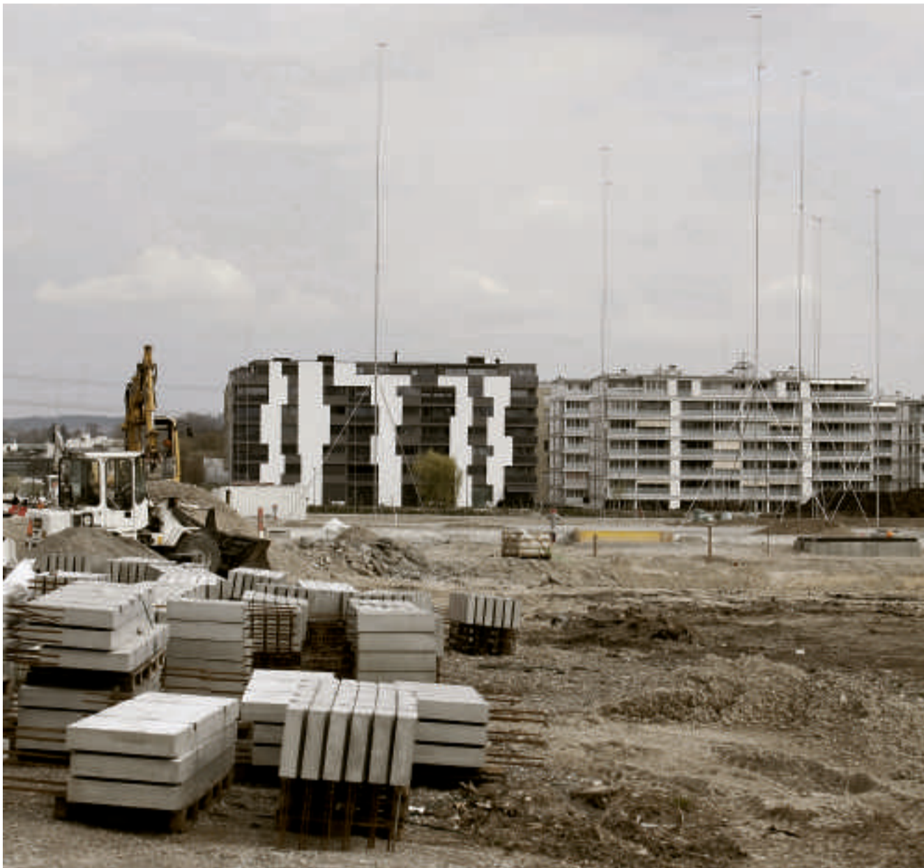
Baugespanne zeigen an, wo im Glattpark die Gebäude der zweiten Etappe errichtet werden. Foto: Sophie Stieger
