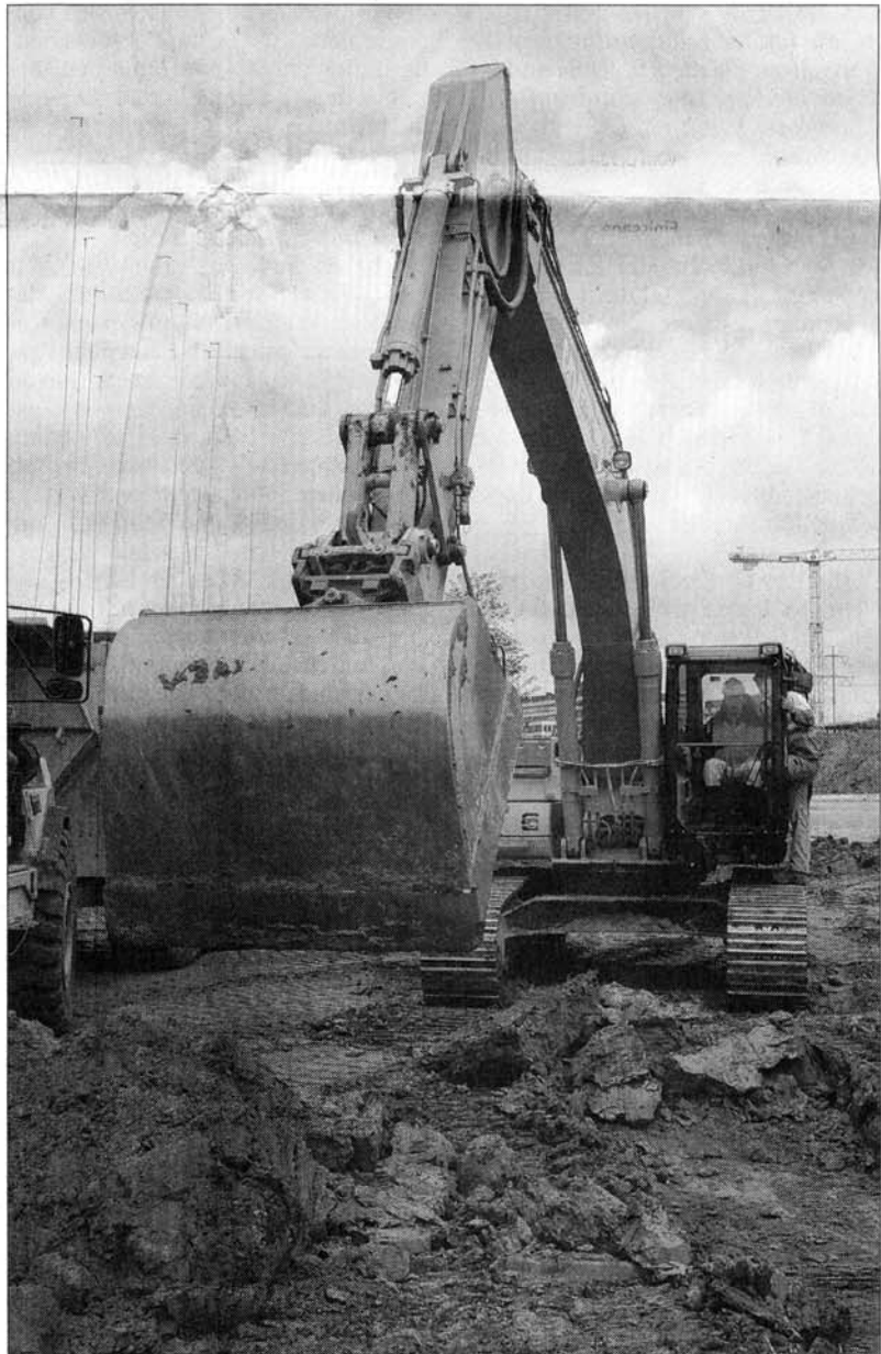
Unter fachkundiger Anleitung hat Hubert Braendle vom UBS Fund Management den Spatenstich mit dem Bagger vollzogen. (mar)
